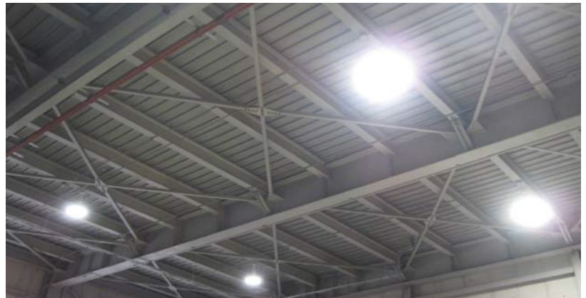
蛍光灯から高天井用LEDセンサーライトに取り替えられたサイチ工業(株)栗東工場内。作業員の方から取替前の蛍光灯よりはるかに明るく、またLEDにしては眩しくないと好評です。
