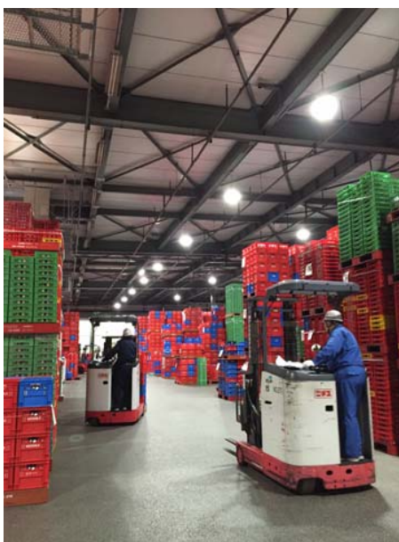
検知エリアにフォークリフトが入ると、照明が自動点灯します。
