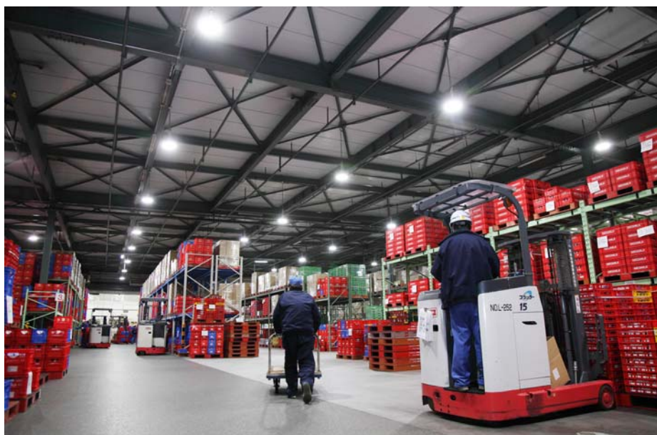
24時間稼働する雪印メグミルク野田工場冷蔵庫庫。20%の明るさを保つほんのり点灯機能を活用し安全面を確保しつつ更なる省エネを実現しています。
