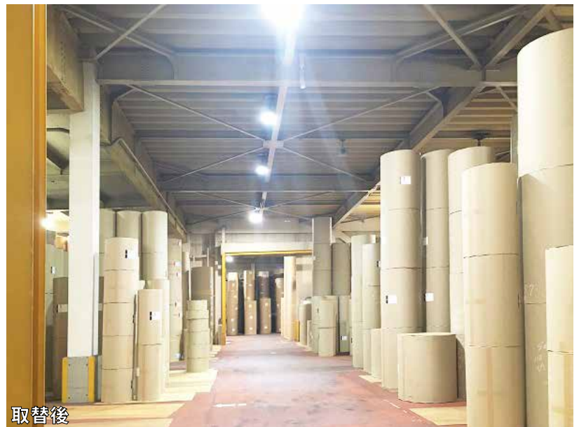
LEDへの取り替えにより照度が3~5倍アップ。照明が点灯していると、人やフォークリフトが近くにいる目印にもなるため、注意喚起の観点からもセンサーライトは役立っています。
