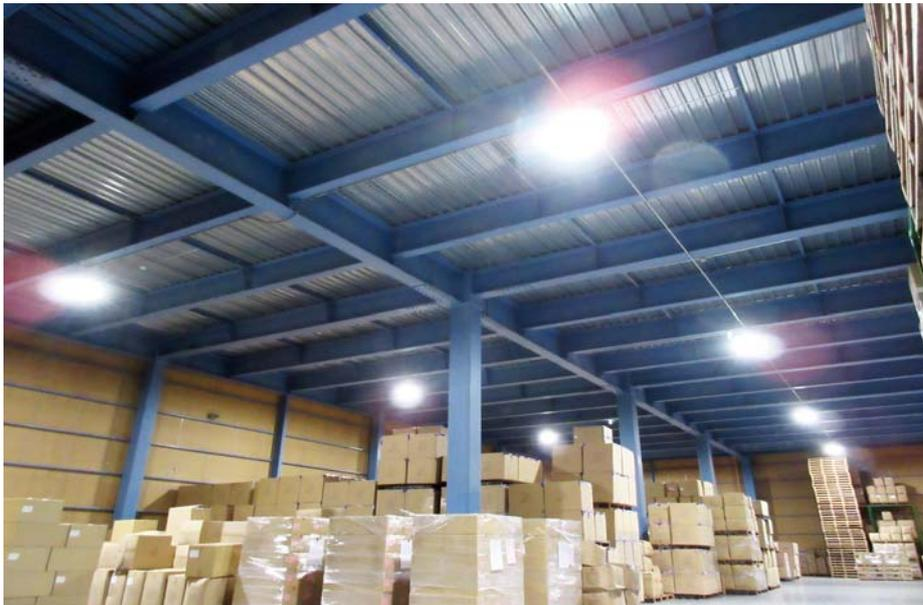
平均照度は取替前の水銀灯と比較して 30% アップしました。センサー制御により、照明が必要な時はより明るく、不要なときは消灯するメリハリのある作業環境が実現しました。
