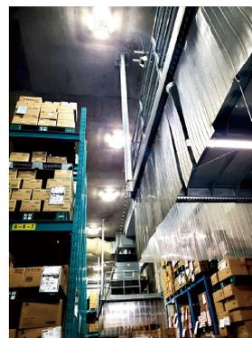
(写真左) 導入後、床面照度が150luxから300luxへUP!
